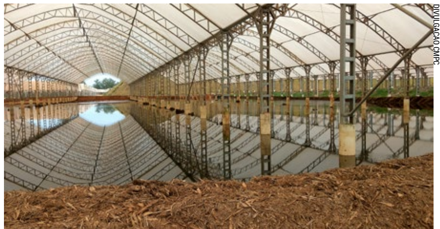
Um dos vários leitos e etapas de secagem do lodo do Hub CMPC de Economia Circular
