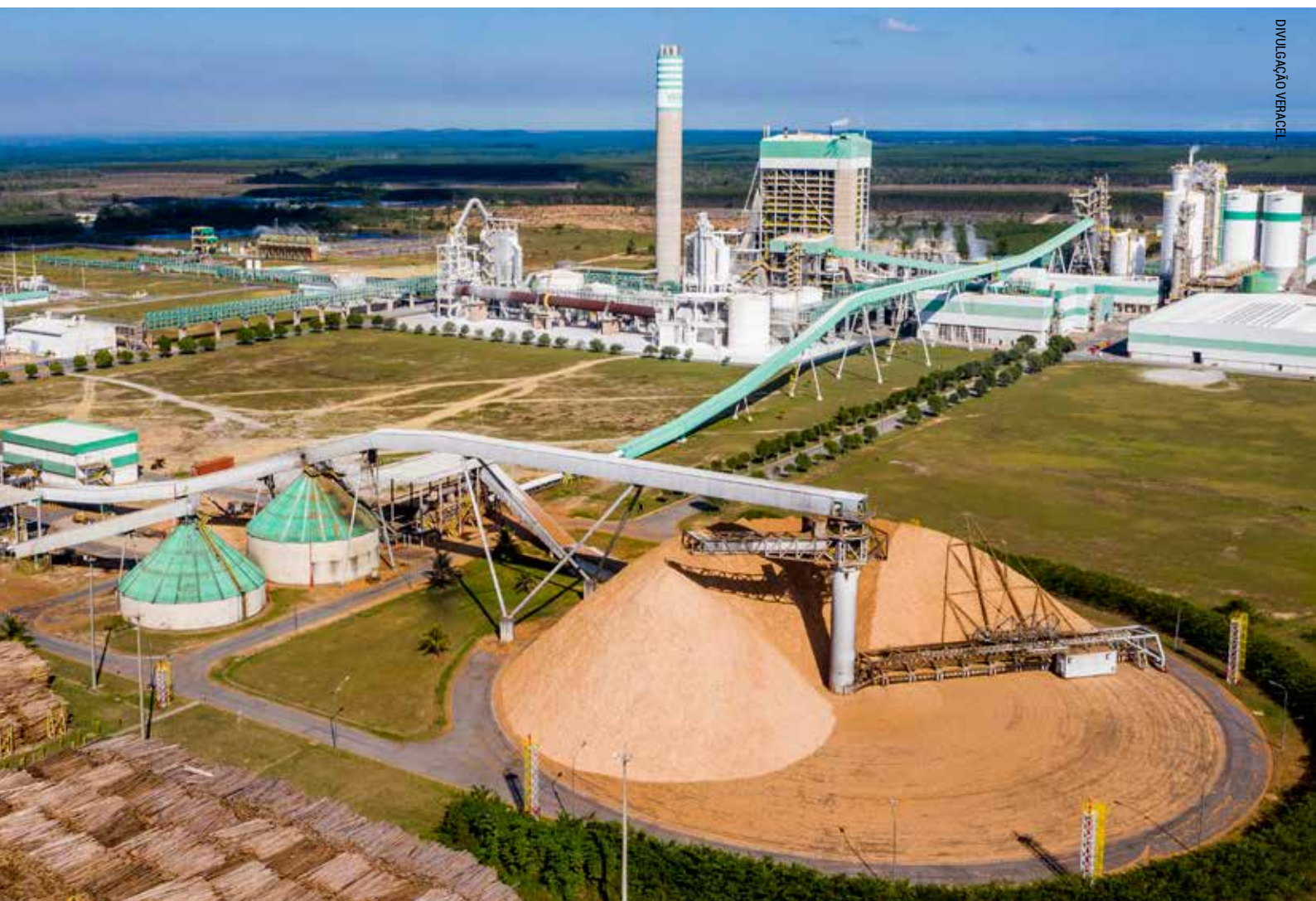
O processo industrial da Veracel começa no momento em que a madeira de eucalipto, colhida e processada para toras de 6,5 m, é levada para a fábrica
